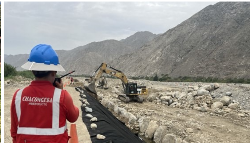
TRABAJOS DE PREVENCIÓN RUTA 16 MOVIMIENTO DE TIERRAS CARRETERA PATIVILCA - CONOCOCHA CONTRATO : 10 MESES
