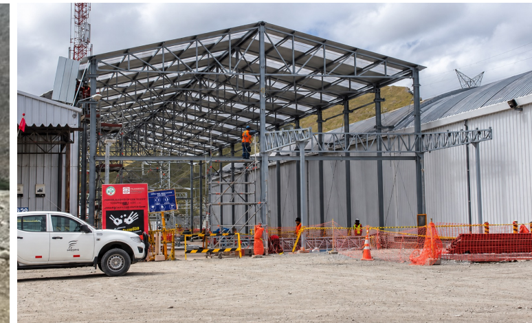
NUEVO ALMACEN CONCENTRADORA EEMM, OBRAS CIVILES, PROTECCIÓN CONTRA DESCARGAS ATM.
