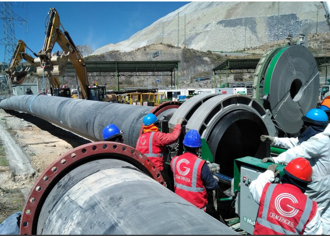
AMPL. ALMACÉN CONCENTRADORA COMPAÑIA MINERA ANTAMINA O.CIVILES Y ELECTROMECANICAS – PATIO CONCENTRADORA.
